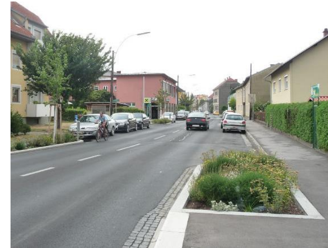
Beispiel für Baumscheiben mit Längsparker auf bestehende Fahrbahnen (Graz)
