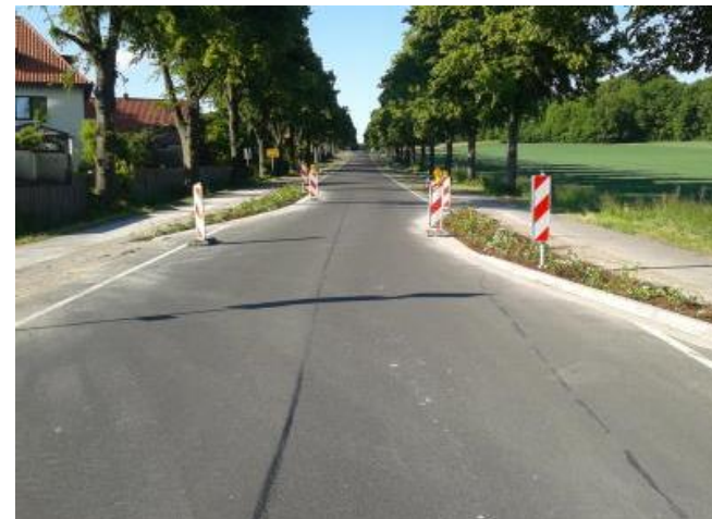
Beispiel einer Ortseinfahrt durch eine Verschwenkung (Weetzen)
