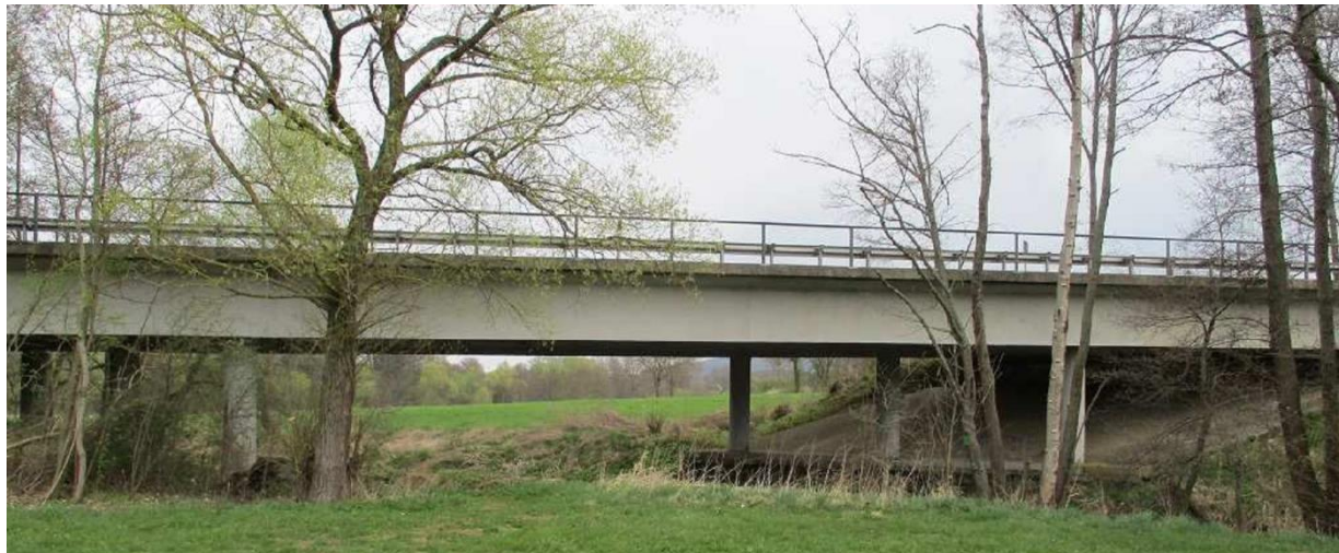
Brückenansicht von der Seite Bildquelle: Hessen Mobil
