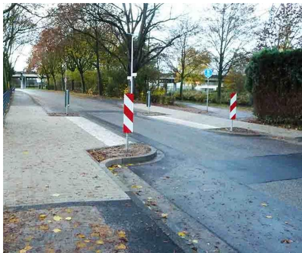
Beispiel einer Ortseinfahrt durch eine Verschwenkung mit Mittelinsel (Assenheim)
