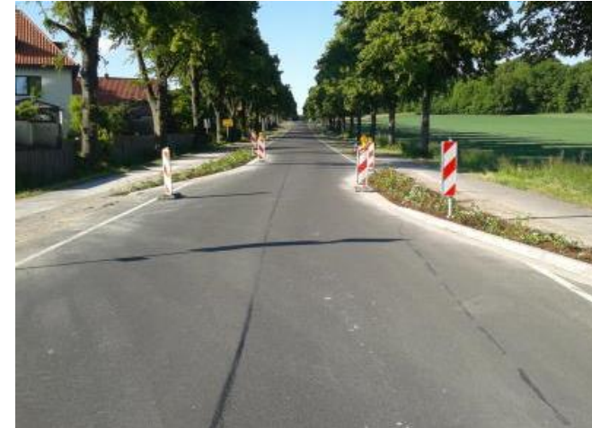
Beispiel einer Ortseinfahrt durch eine Verschwenkung (Weetzen)
