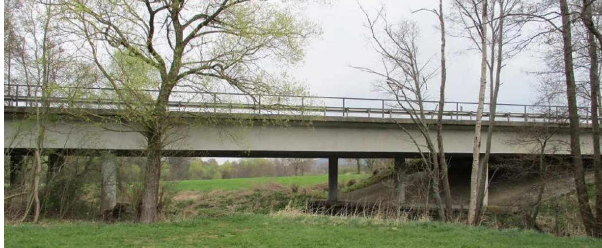
Brückenansicht von der Seite Bildquelle: Hessen Mobil
