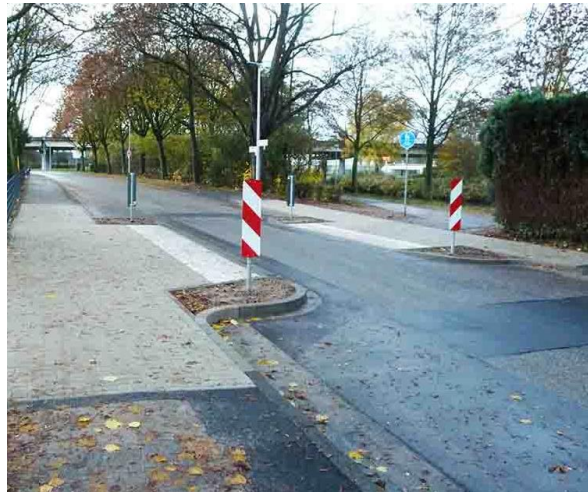
Beispiel einer Ortseinfahrt durch eine Verschwenkung mit Mittelinsel (Assenheim)
