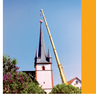
Der Kran neben der Kirchturmspitze.
